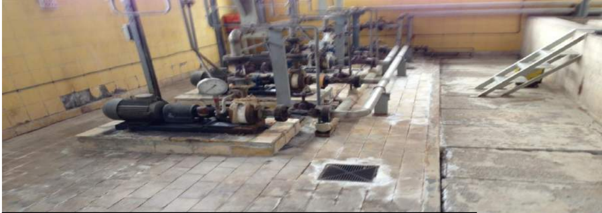
Tasfiyehane mevcut hali.
