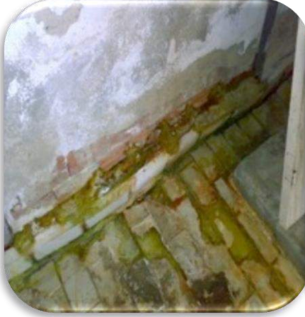
Asit kaçakları bina kolonlarını ve zeminleri eritiyor
