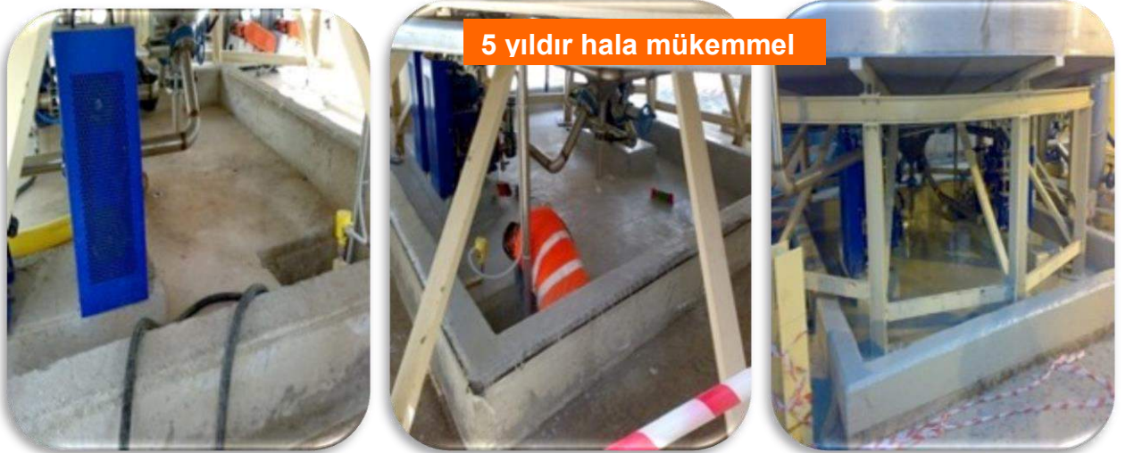
Kaplanmamış hali ENVIRO COAT 1350 MR Kaplama yapılırken 1350 MR Kaplanmış hali
