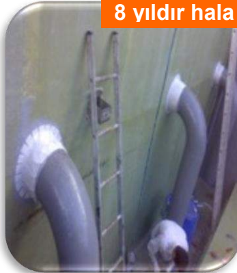
Havuz borularının sızdırmazlığı sağlandı.
