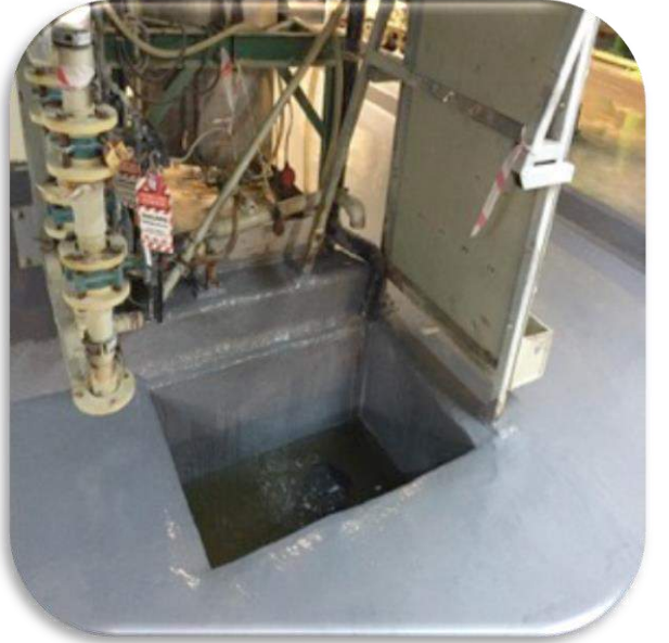
Firmamızın Baymina Enerji'ye yaptığı %98 lik Sülfürik Asit'e rögarı kaplaması
