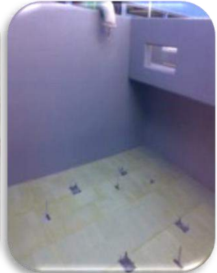
Havuz kanalının ve duvarlarının MR kaplanmış halı
