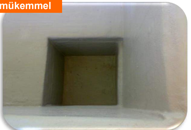
Koza Mastra Asit Rögarı kaplanmadan önce ve MR sistem kaplandıktan sonra
