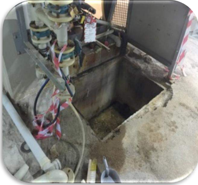
Firmamızın Baymina Enerji'ye yaptığı %98 lik Sülfürik Asit'e rögarı kaplaması
