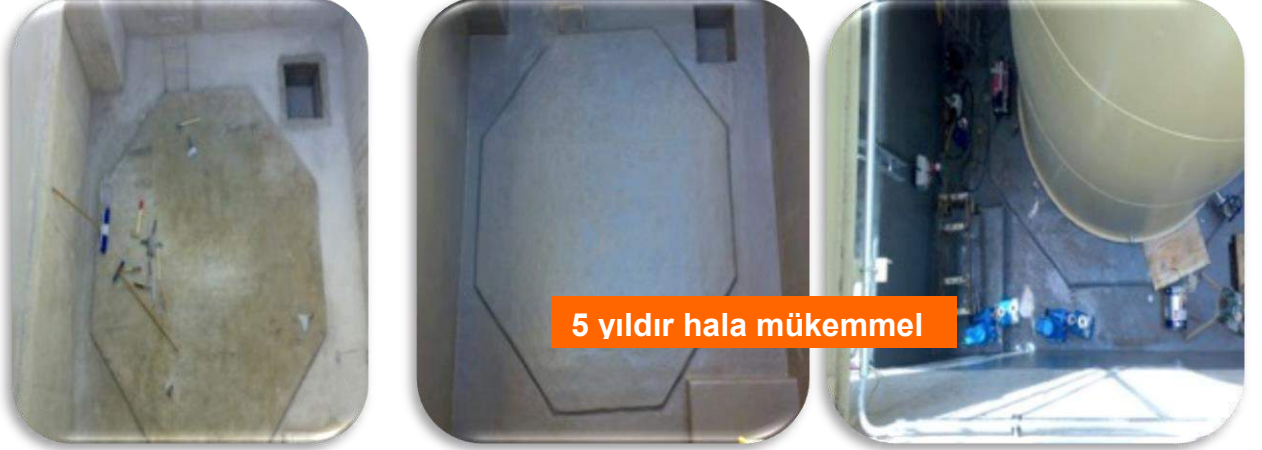
Asit Tank Altı kaplanmadan önce, MR Kaplanmış hali, %98 H2SO4 Tank ve pompa montaj çalışmaları
