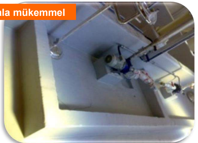
Asit yükleme havuzu kaplanmadan önce ve Enviro Protect 1354 MR sistem kaplanmış hali
