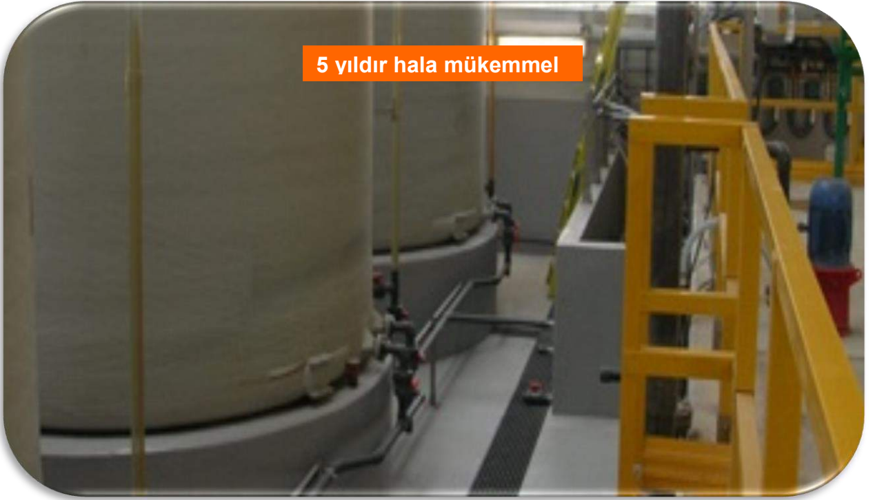
DOW ENVIRO PROTECT HT MR FLAKELINE SİSTEMİYLE kaplanmış Sıcak kimyasal tankların bulunduğu ELEKTROLİZ alanı
