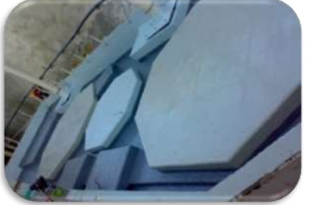
Enviro Protect ile kaplanmış Flotasyon alanı
