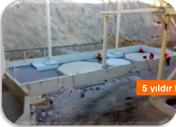
1352 MR ile kaplanarak montaja hazır edilmiş FLOTASYON alanı 1352 MR Kaplanmış alanın üzerine kurulmuş FLOTASYON tesisi
