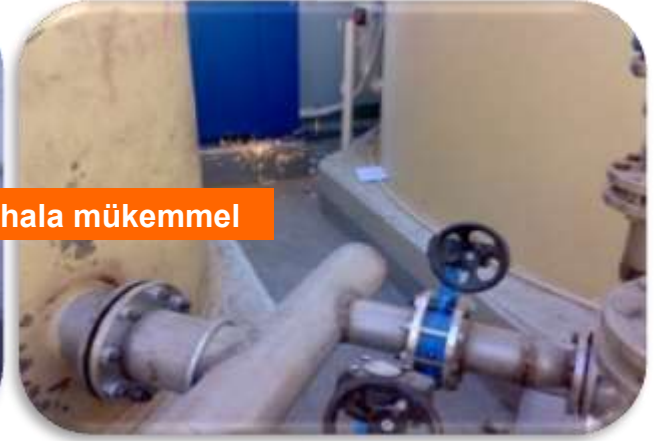
1352 MR kaplanarak montaja hazır edilmiş tank ve pompa alanı. 1352 MR kaplanmış yüzey üzerinde montaj yapılırken
