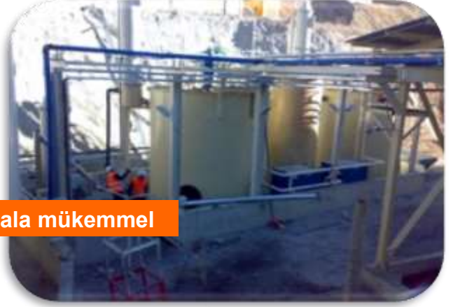
1352 MR ile kaplanarak montaja hazır edilmiş FLOTASYON alanı 1352 MR Kaplanmış alanın üzerine kurulmuş FLOTASYON tesisi
