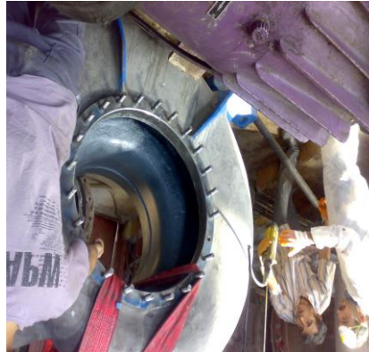
EURO COAT 1357 MR kaplanmış hali montaj sırasında
