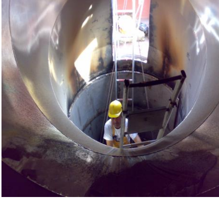
Baca gazı arıtma borusunun kaynak tamiri yapılırken
