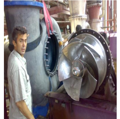
EURO COAT 1357 MR kaplanmış hali montaj sırasında
