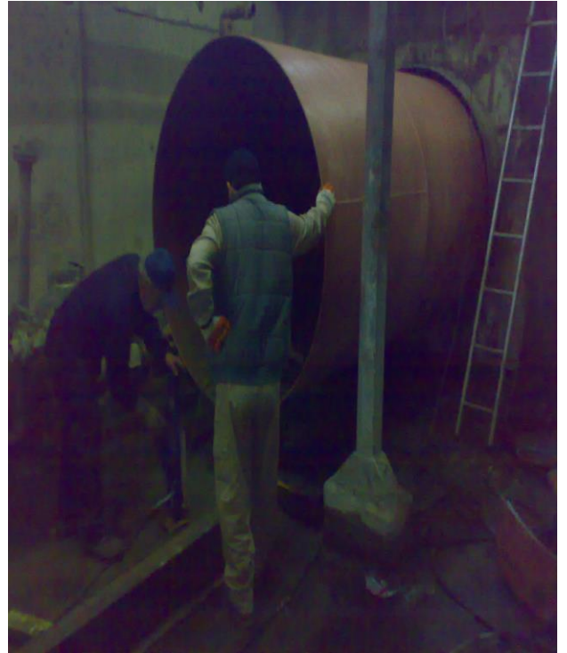
Boru içine boru montajı yapılırken
