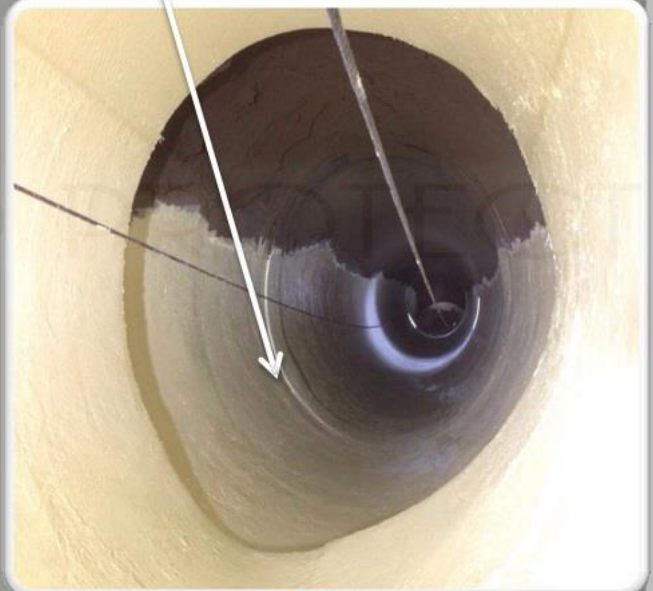
İsdemir 2. Boru Sıvı Seramik Flake kaplanmış hali
