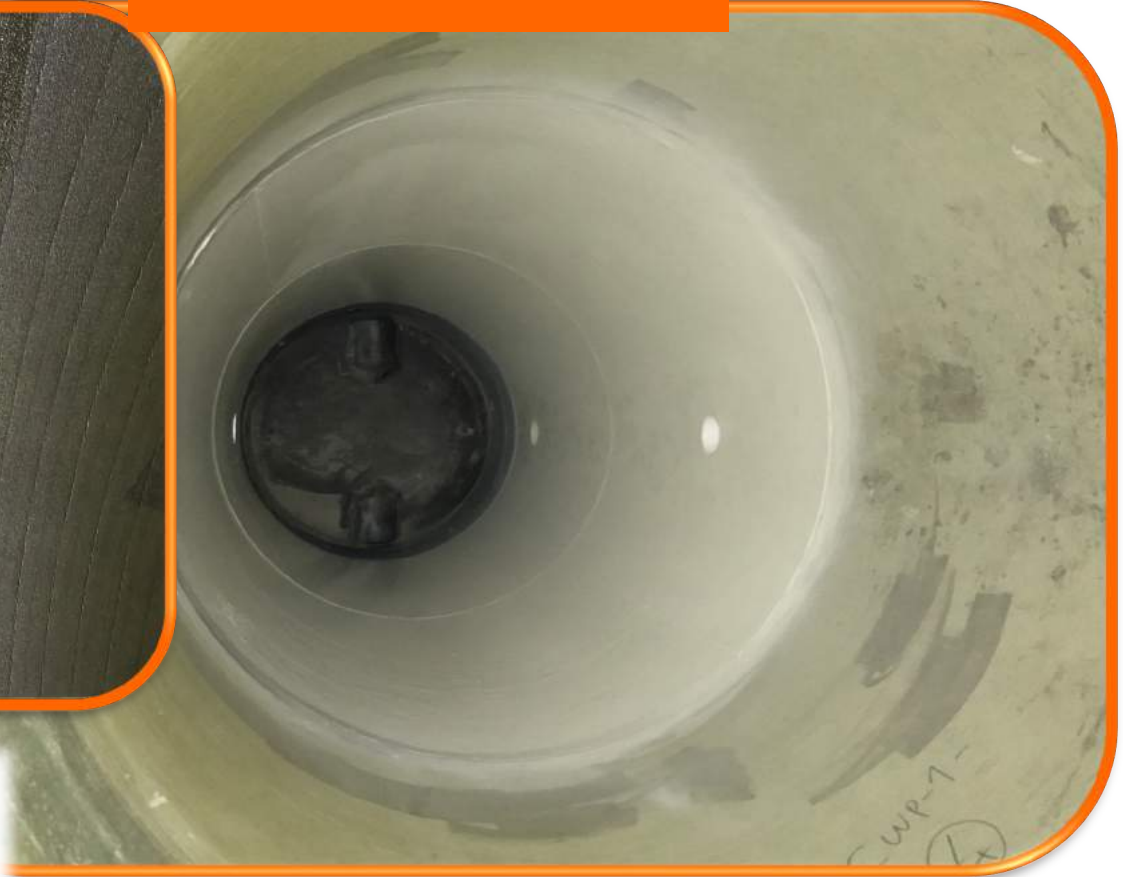
Sıvı Seramik Kaplanmış ve Elastomer Dolguların yapılmış hali
