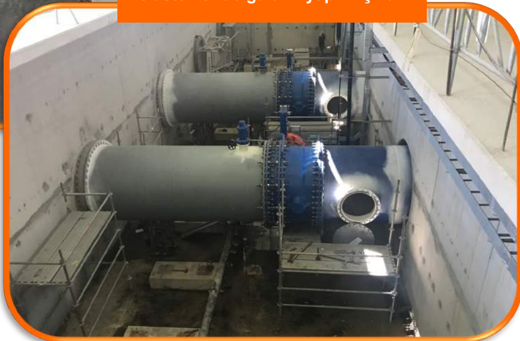
Sıvı Seramik Kaplanmış ve elastomer dolguların yapılmış hali
